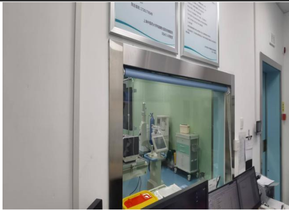
DSA 机房东侧控制室铅玻璃观察窗
