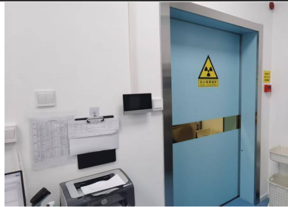
DSA 机房东侧医生通道门
