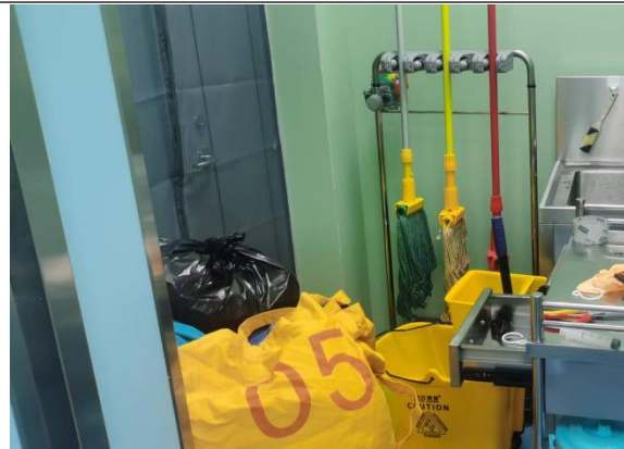
DSA 机房西侧污物间
